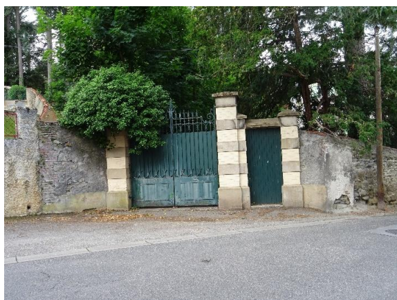
Ancienne entrée sur la rue Michel Laval
