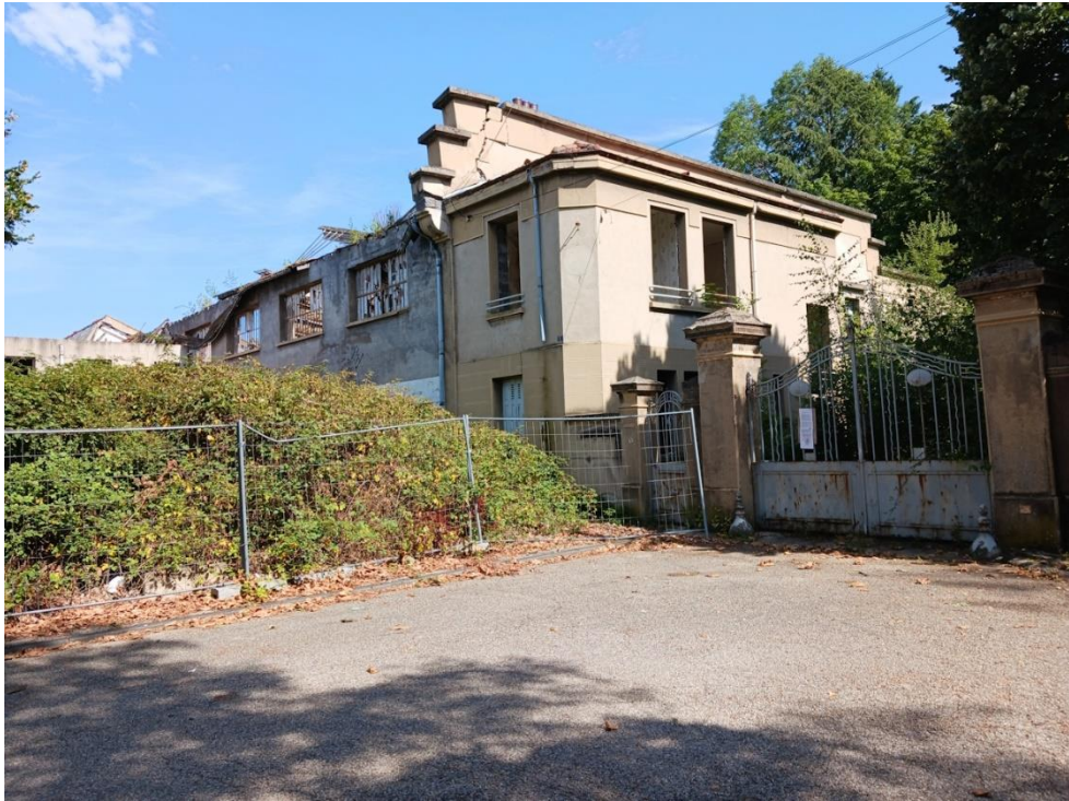
Entrée de l'usine rue de la Chapelle
