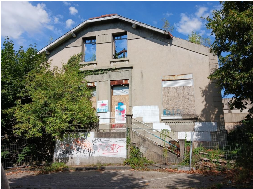
Façade de l'entrée
