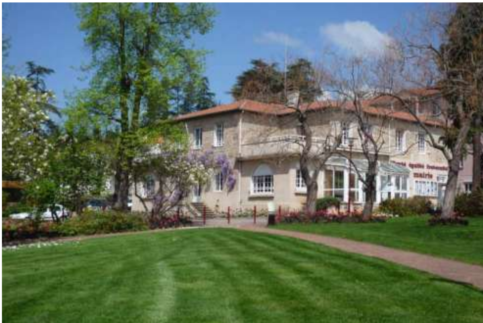
La façade sur le parc (C. Allemand)
