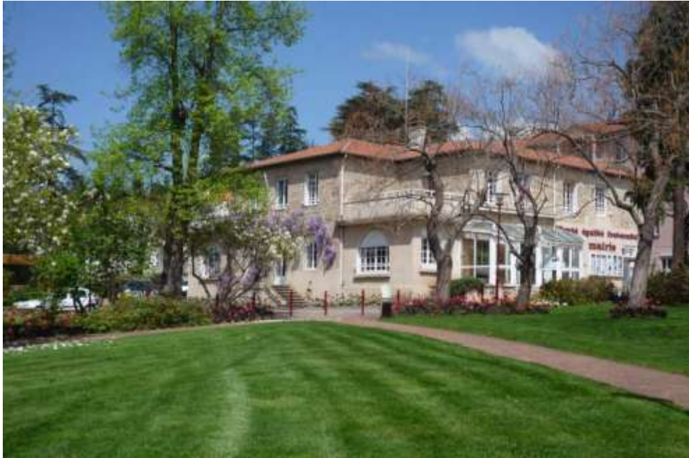
La façade sur le parc (C. Allemand)
