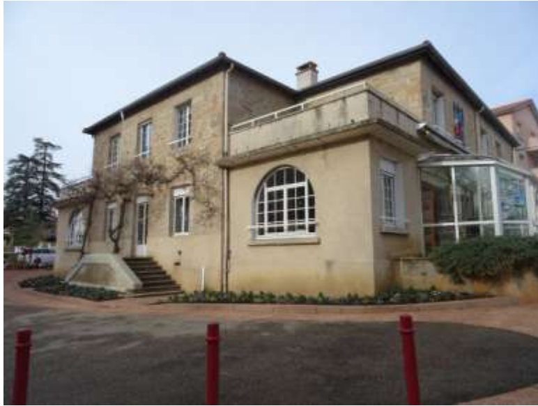
Vue de la façade sur le parc
