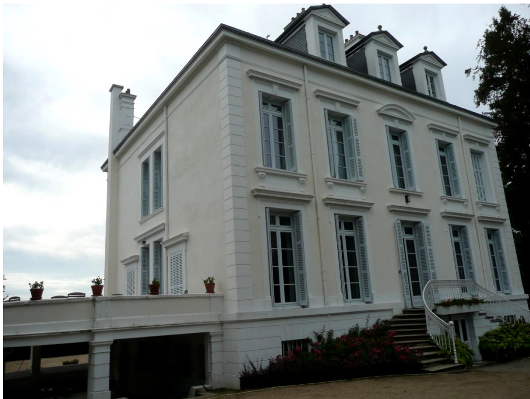
Façade est sur la rue Villemagne
