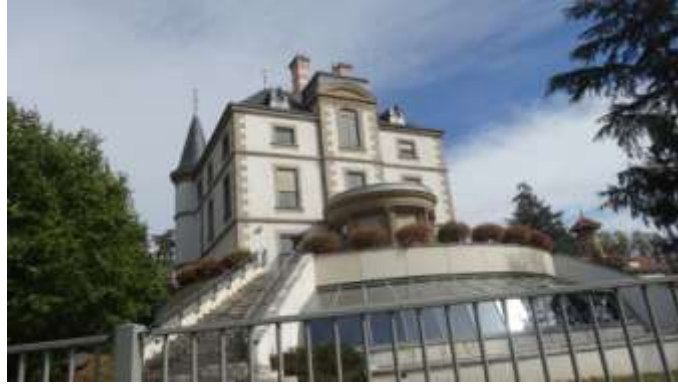
Le perron après réaménagement de la serre
