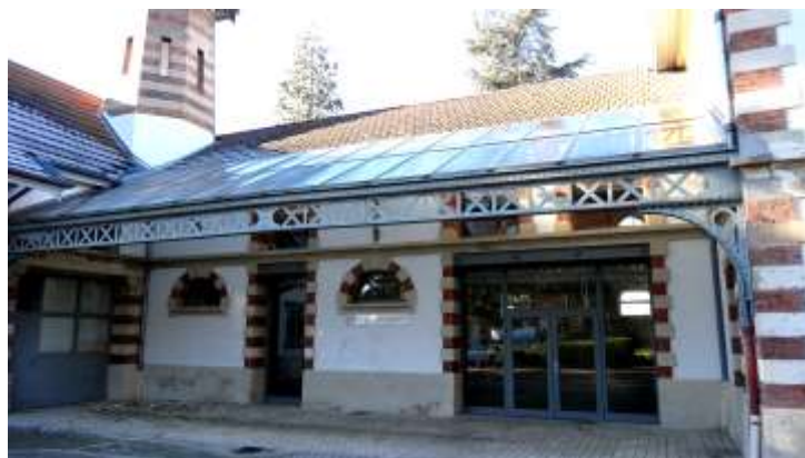
Utilisation du fer pour les poutres
