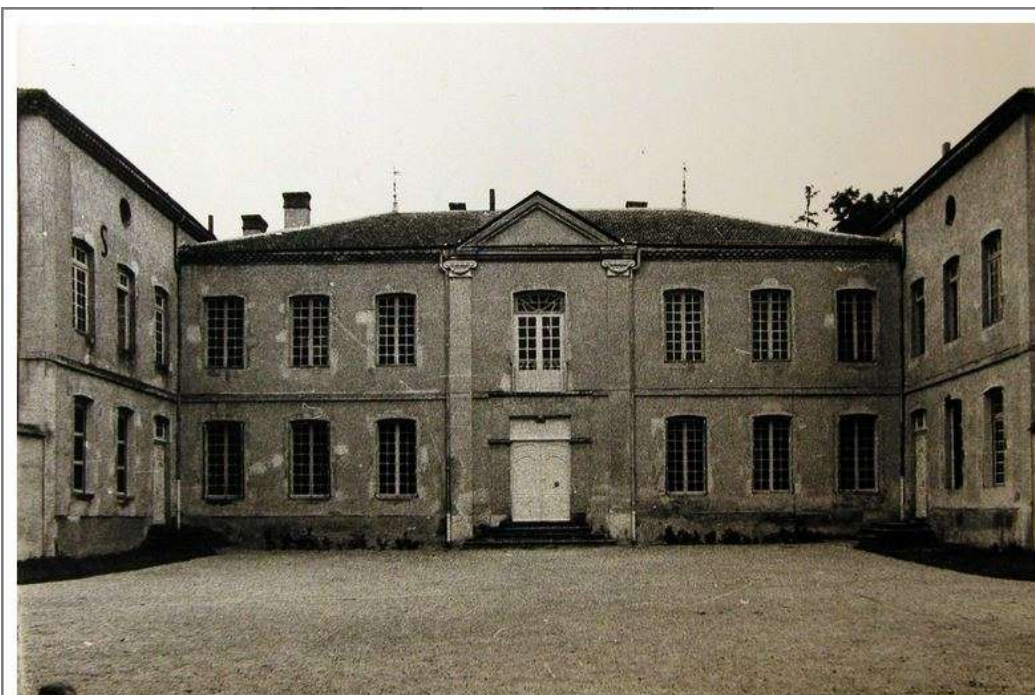
Demeure, dite château de Champs - Vue d'ensemble de la maison de maître, depuis l'est, vers 1974 Dossier de recensement MH établi en 1974. Photographie argentique en noir et blanc. AD Loire. 1111 VT 133
