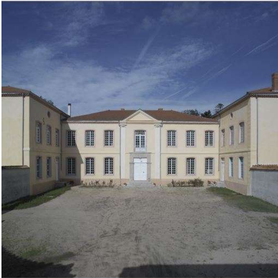
Demeure, dite château de Champs - Vue d'ensemble de la maison de maître, depuis l'est.
