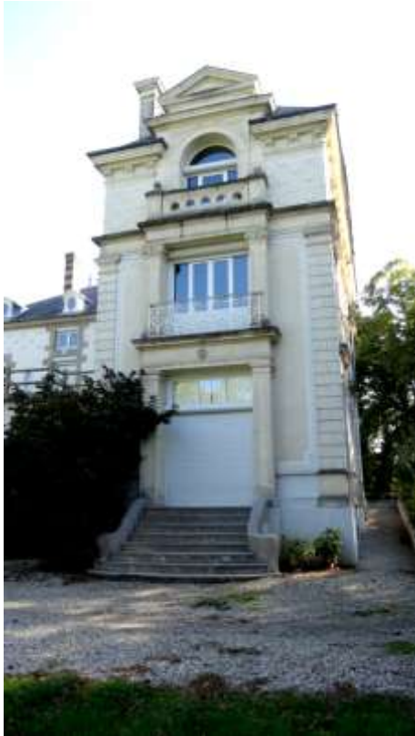
Détail de la façade est
