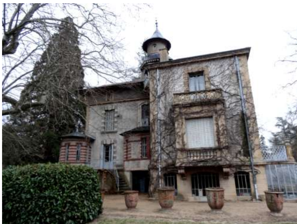
Vue actuelle de la façade ouest
