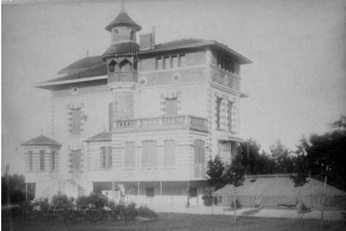
Vue de la façade ouest avant modifications
