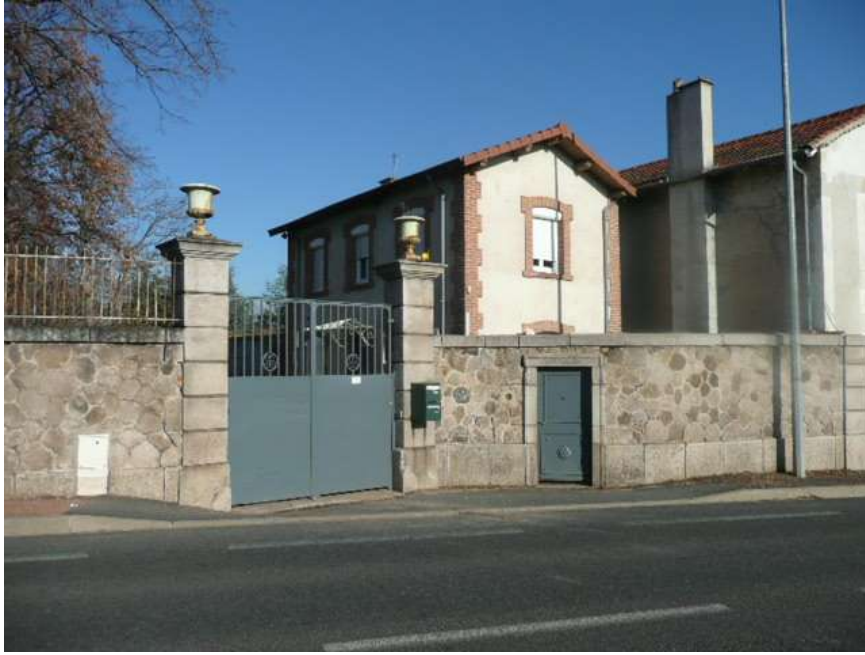
Entrée au 11 avenue de St Rambert : elle donne accès à une longue allée plantée d'arbres qui mène au château. Maison de gardien à droite.
