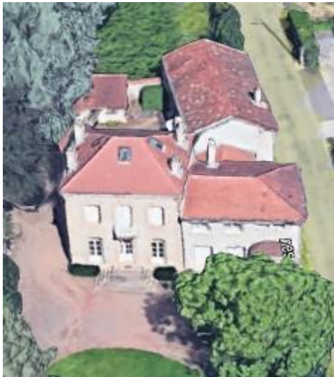
Les bâtiments associés
