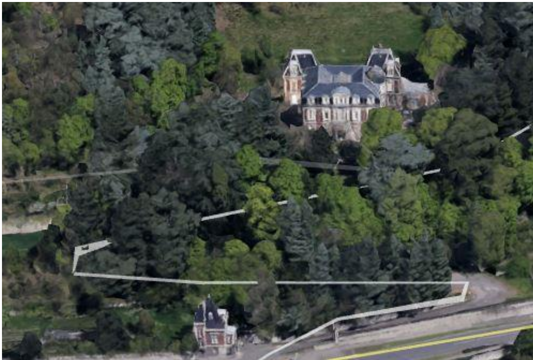
Le site du château avec maison de gardien sur la route. L'emplacement du portail a été déplacé au XX e siècle
