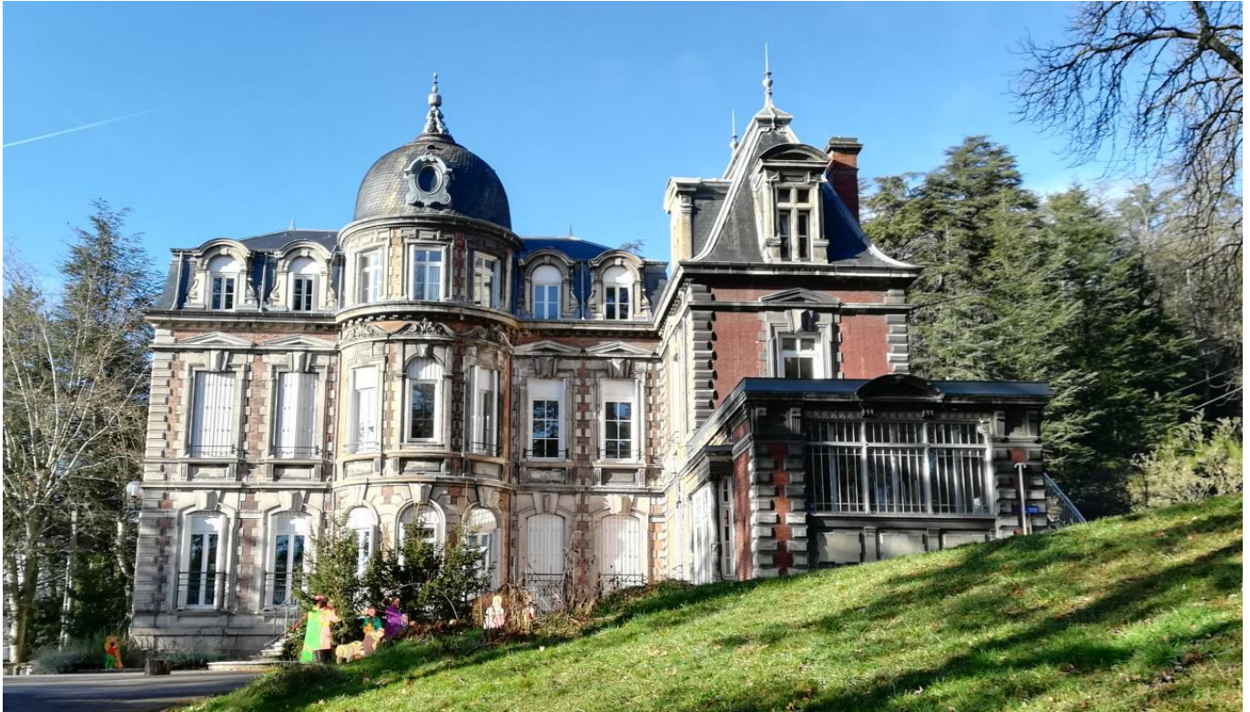
Vue latérale qui souligne un traitement assez proche de la façade principale. (photo M. Bonneville) On remarque comment l'avant corps est surmonté d'une coupole en forme de dôme, percé d'un oculus. On peut discerner sur la droite les bâtiments qui ont été ajoutés, prenant la place d'une serre vitrée de forme arrondie.
