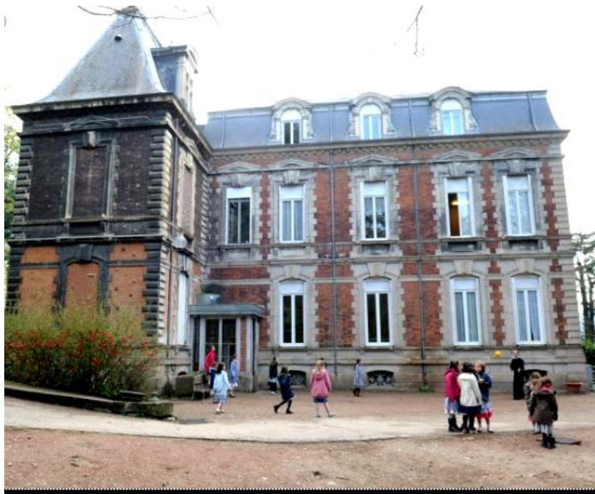
Vue de l'arrière du château à présent occupé par une école
