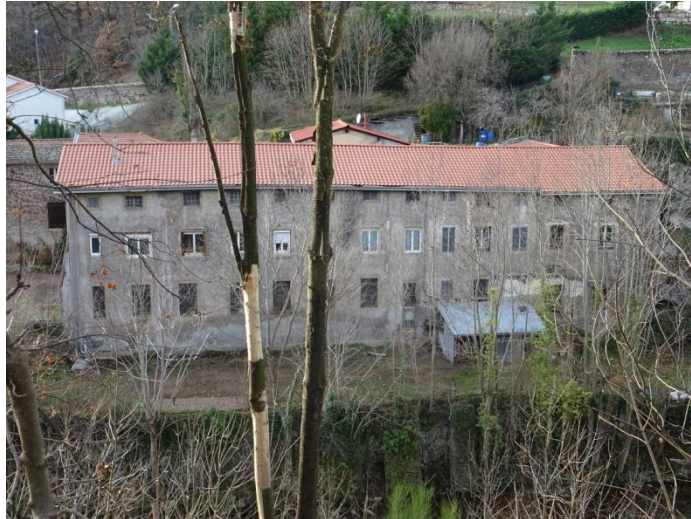
Les bâtiments de l'usine pensionnat du moulinage du Rochain au bord du Dorlay
