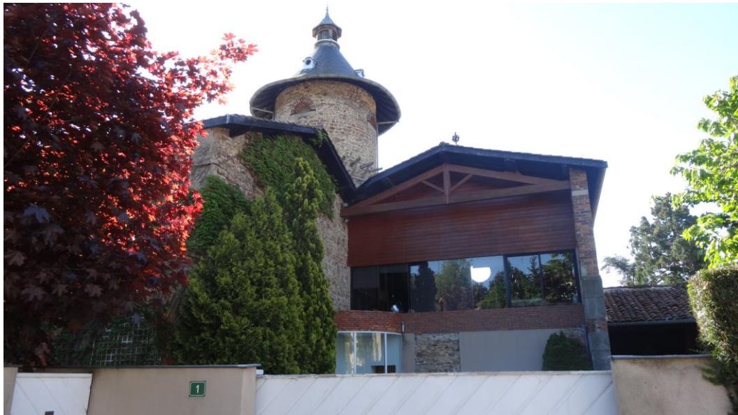
Bâtiment avec pigeonnier restauré
