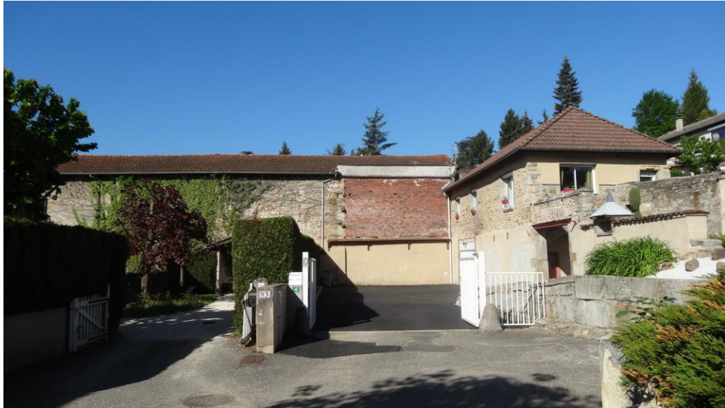
Bâtiments de ferme restaurés
