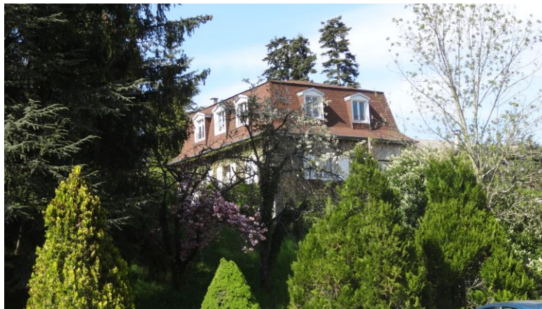
Bâtiment ancien rehaussé d'un étage
