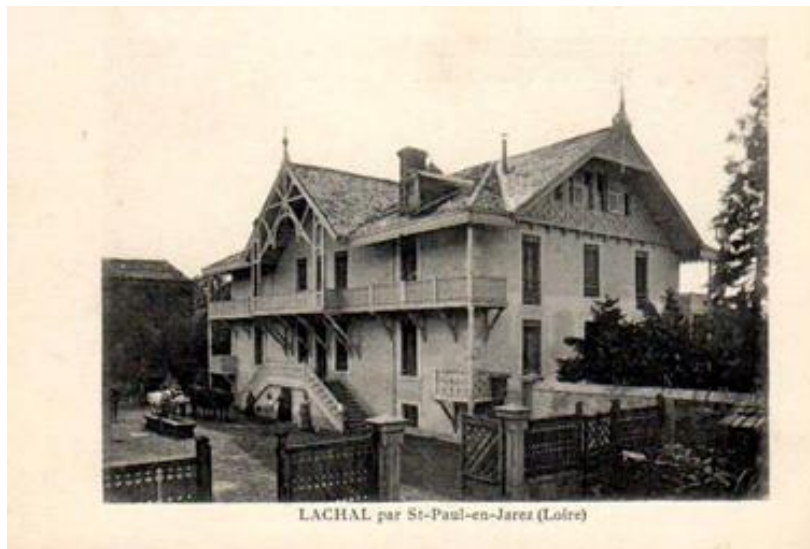
Vue du chalet dans son état primitif
