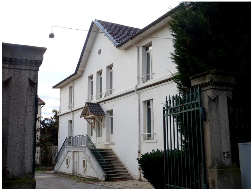
La façade sud dans son état actuel
