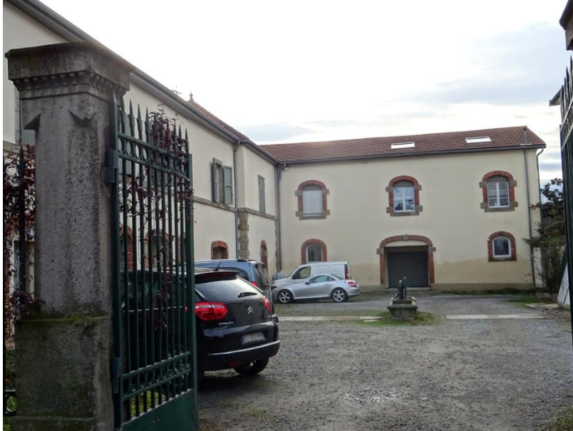
Vue de la cour du domaine et de son pavage, avec les bâtiments plus anciens qui accueillent la ferme, les logements des employés
