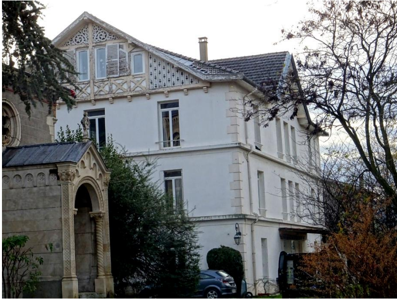
La façade nord, avec au premier plan la chapelle
