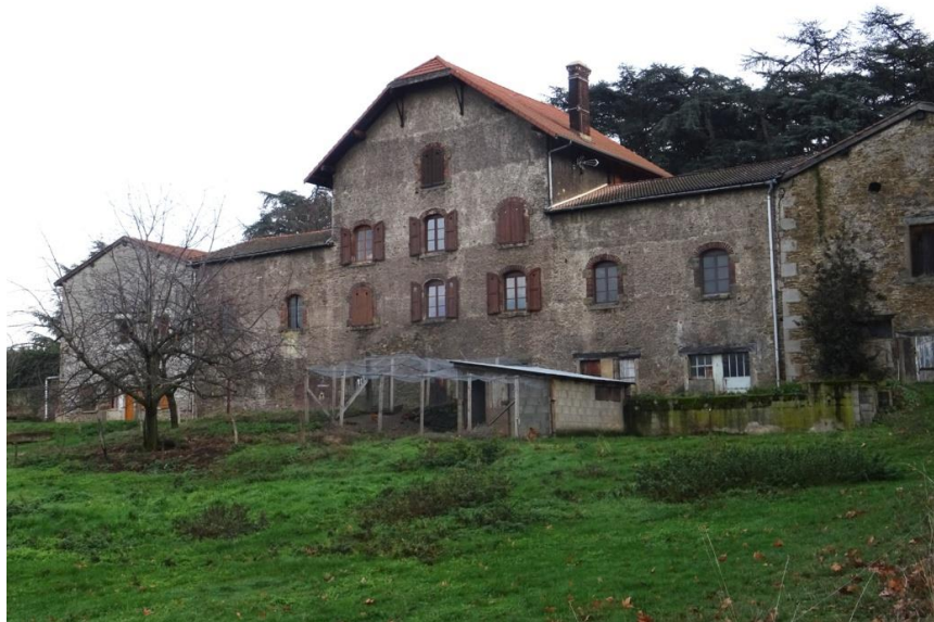
La ferme de Lachal. Façade nord
