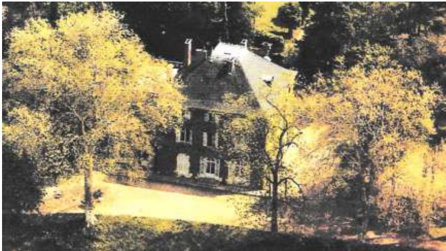
Vue aérienne de la maison en 1932. Façades couvertes de vigne vierge
