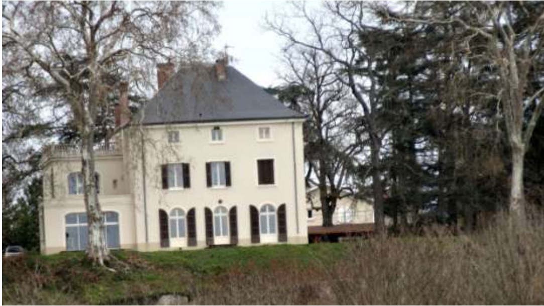
La façade ouest dominant la Loire avec le bâtiment accolé ajouté en 1911
