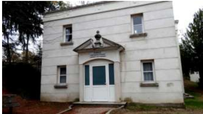
Bâtiment annexes d'habitation ( ?) avec d'un fronton entrecoupé couronné d'une cimaise.
