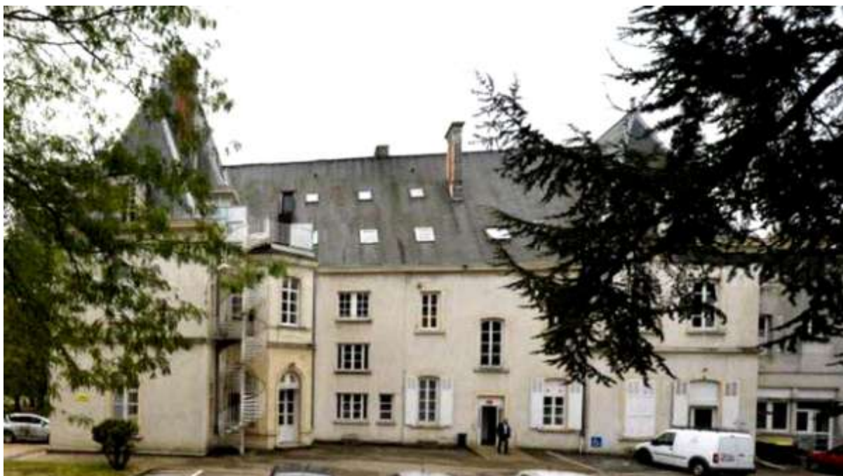
Vue actuelle avec ajouts : escalier de secours à gauche et bâtiment de cuisine à droite
