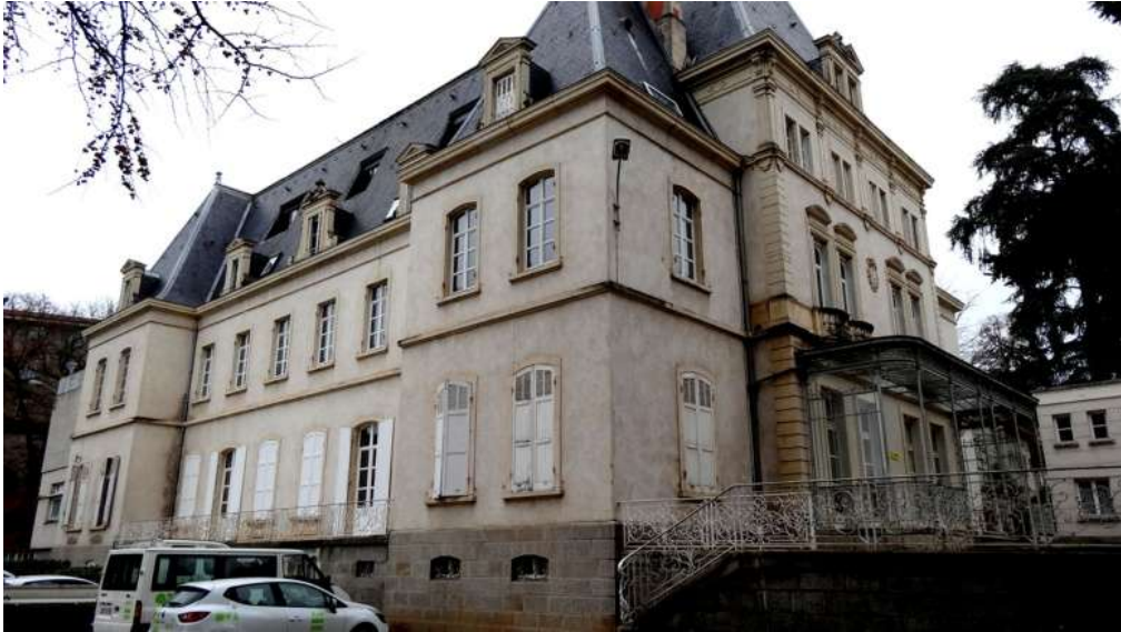
Organisation de la façade avec 2 ailes avancées encadrant le corps central.
