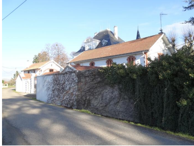
Façade latérale sur rue occupée par les communs
