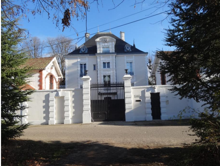
Façade ouest sur rue
