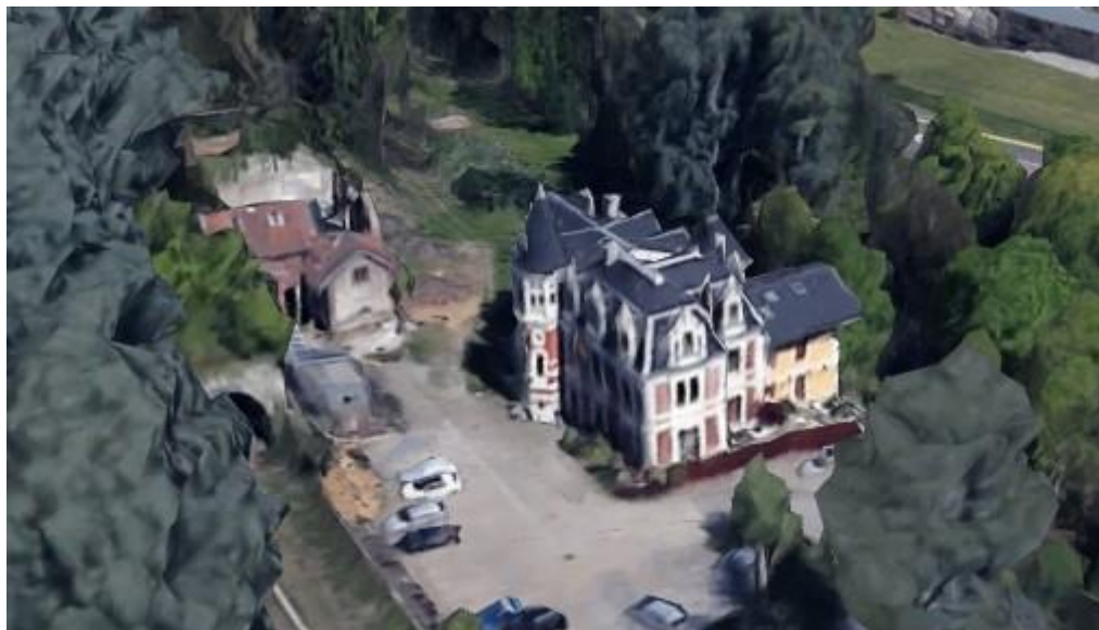
Le château à l'entrée du tunnel.
