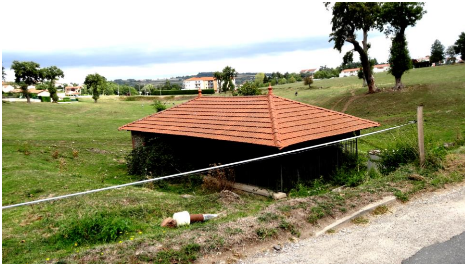
Le lavoir. On peut aussi voir le vaste pré qui a échappé à l'urbanisation à ce jour
