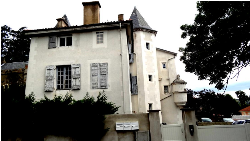
Le bâtiment ancien de style sobre, avec une tour centrale
