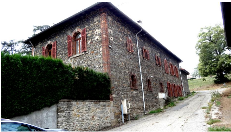
Bâtiment annexe du château comprenant des logements pour les employés
