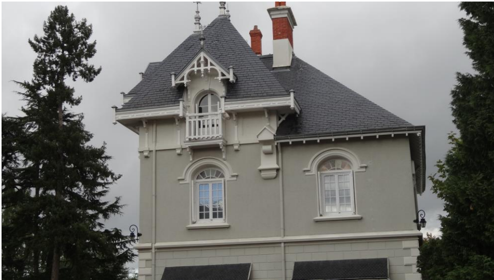
Façade latérale avec le belvédère
