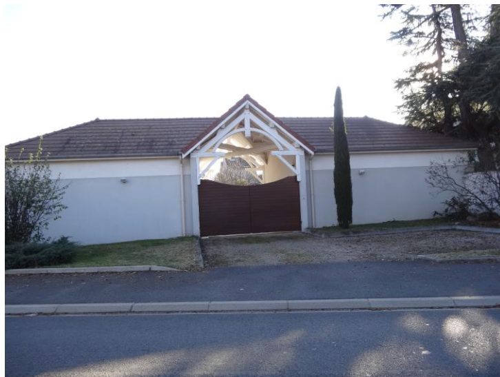
Bâtiment annexe (garages)
