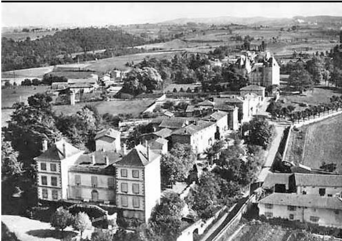
Vue aérienne : au premier plan La Vigie et en fond le château de Saint-Bonnet. A droite, de l'autre côté de la rue, le Clos et les bâtiments de ferme du château
