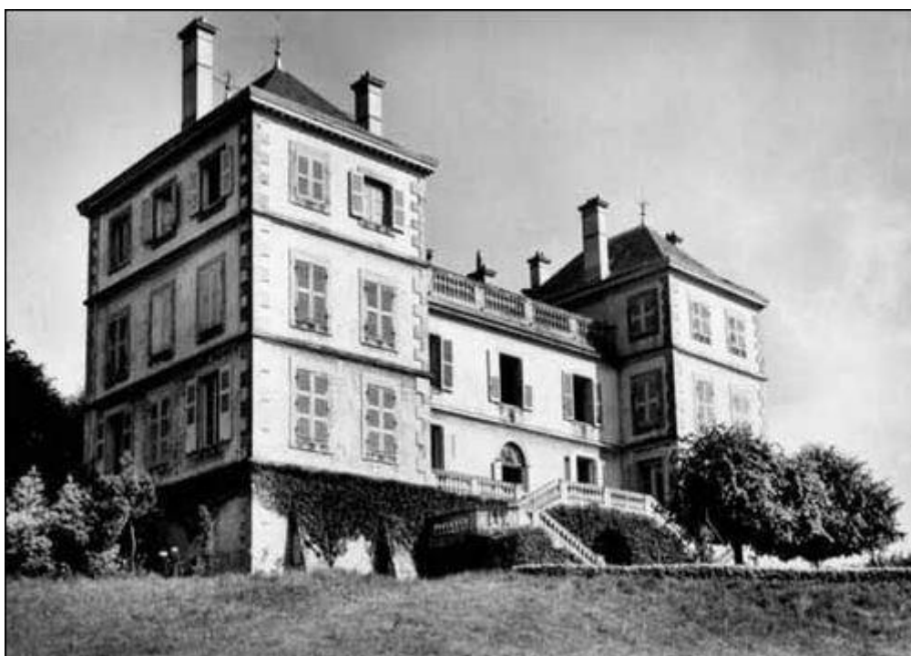
La façade ouest après travaux
