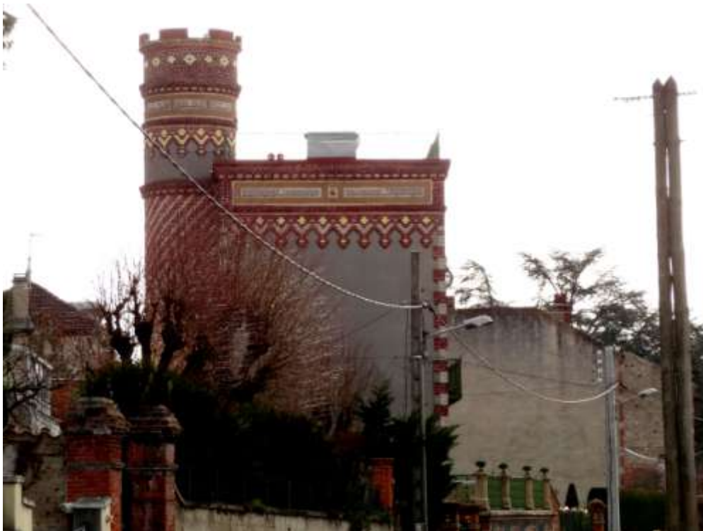
Façade nord et portail d'entrée d'origine.
