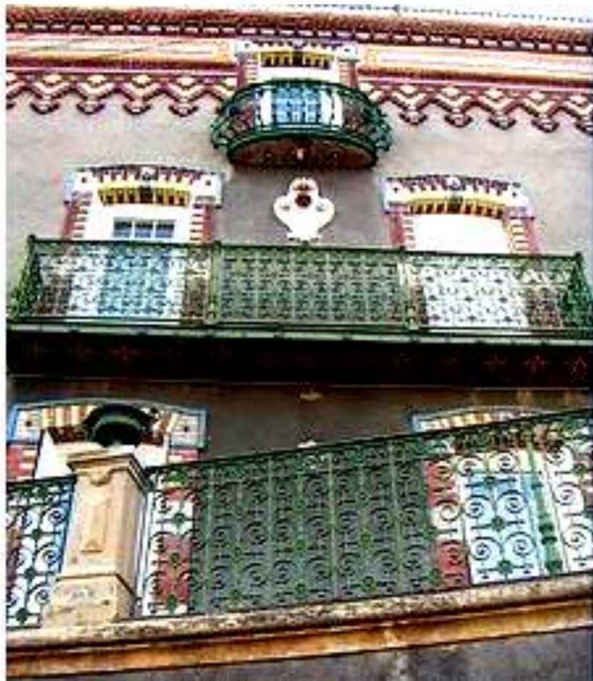
Les balcons en ferronnerie très travaillée
