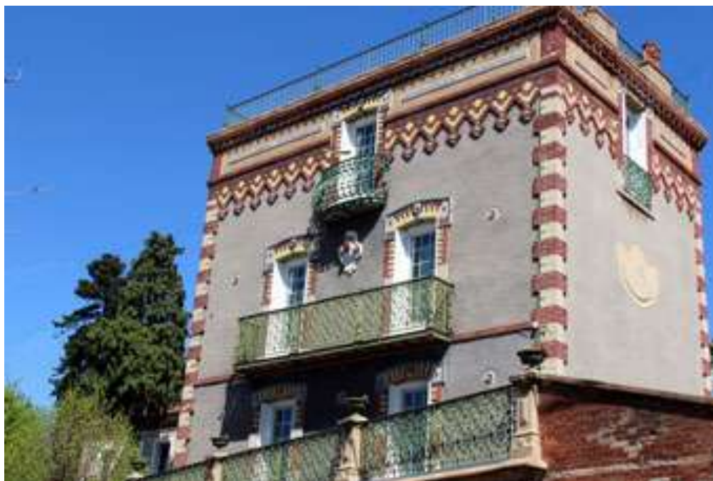
Façade sur rue (photo D. Tabard)
