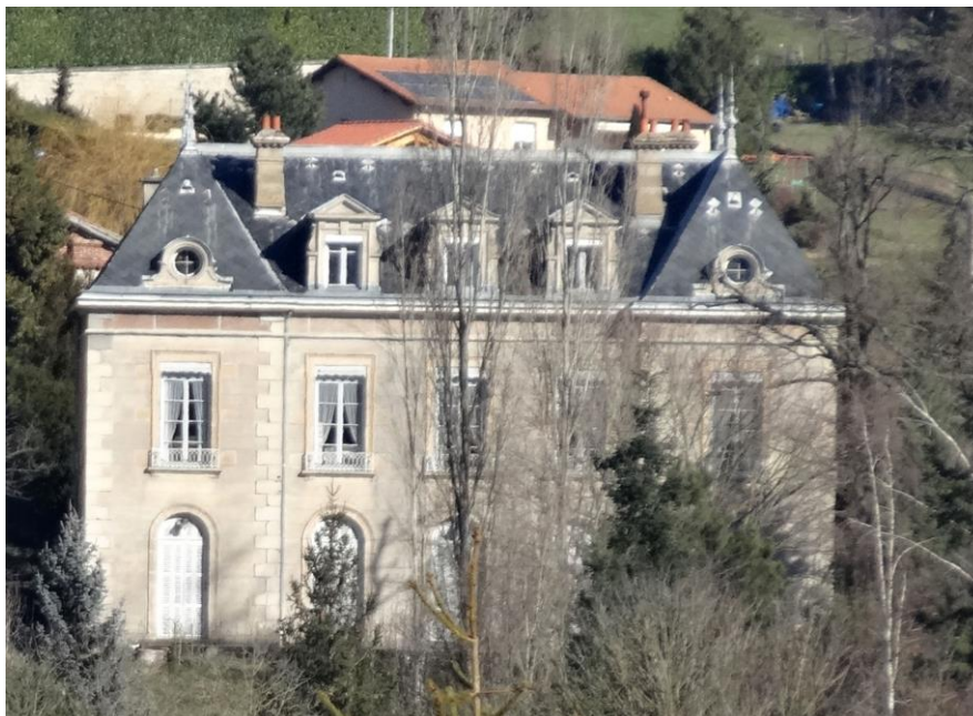
Trois lucarnes à fronton sont insérées dans la toiture et deux oeils de bœuf dans celle des deux ailes de part et d'autre du corps central.
