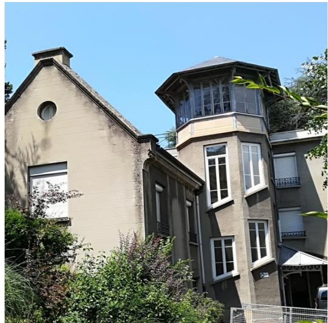
Bâtiments annexes avec tour surmontée d'une salle hexagonale
