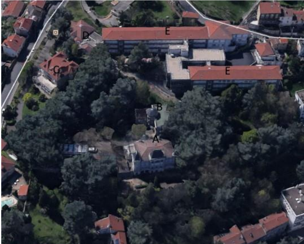
Les différents bâtiments du site. Le château ancien (A)
