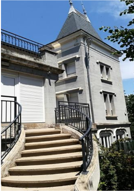
Vue arrière et latérale de la tour carrée. Escalier monumental d'accès à l'étage
