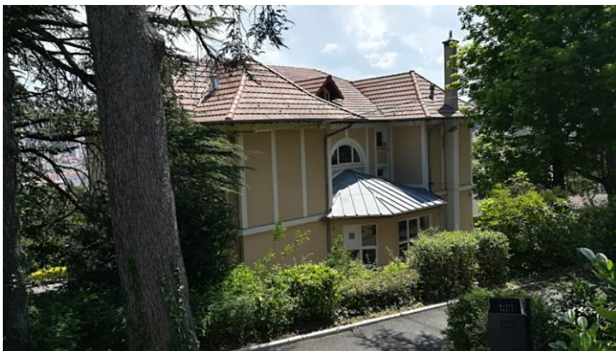
Arrière de la maison avec petite véranda
