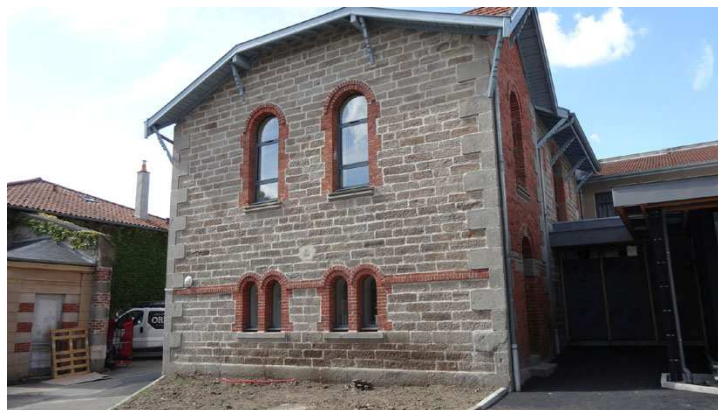
Bâtiment d'écurie rénové pour accueillir des cuisines en rez-de-chaussée et des salles de cours à l'étage
