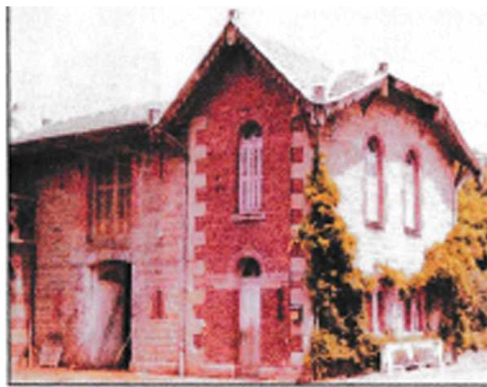
La vacherie et la maison du jardinier dans leur état avant restauration
