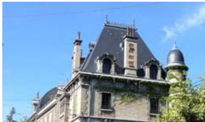
Toiture avec lucarnes en mansarde, tourelle coiffée d'un dôme et cheminées décoratives. Photo d'après A. Picon
