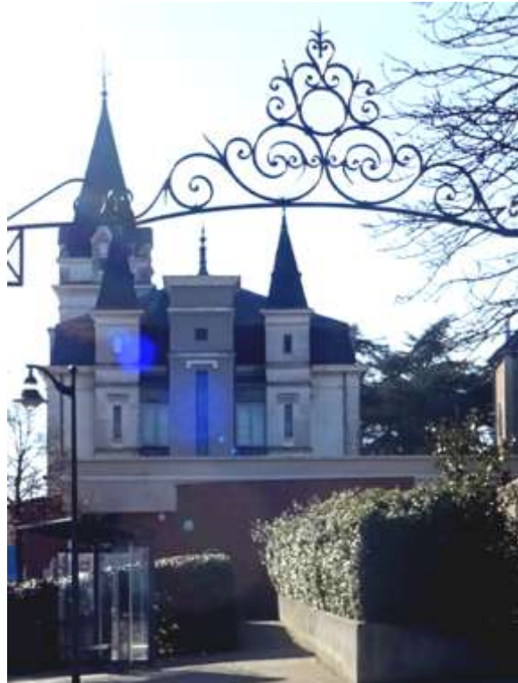
Façade est : deux tourelles d'angle et une construction ajoutée pour escalier de sécurité
