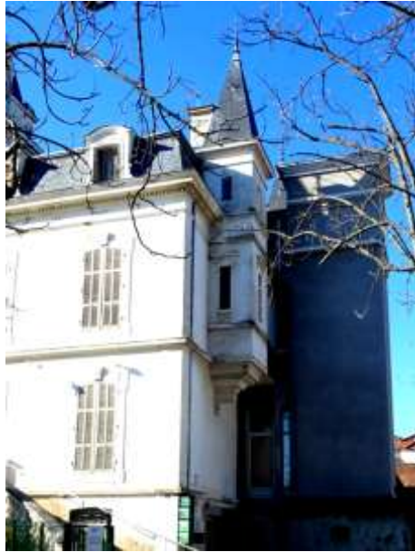
Tourelle d'angle percée de fenêtres
