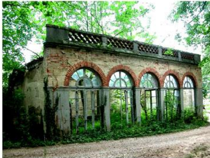
Vue d'ensemble de l'orangerie.
