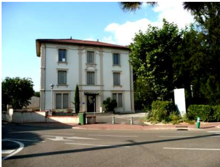
Façade sur la rue
