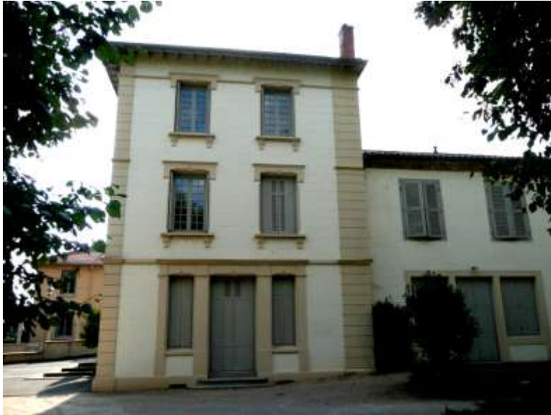
La même façade sur le parc après travaux
