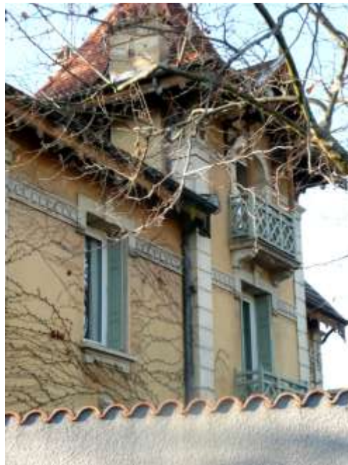
Décorations de la façade : chaînages d'angle; frises, encadrements de fenêtres ; balcons sur consoles
