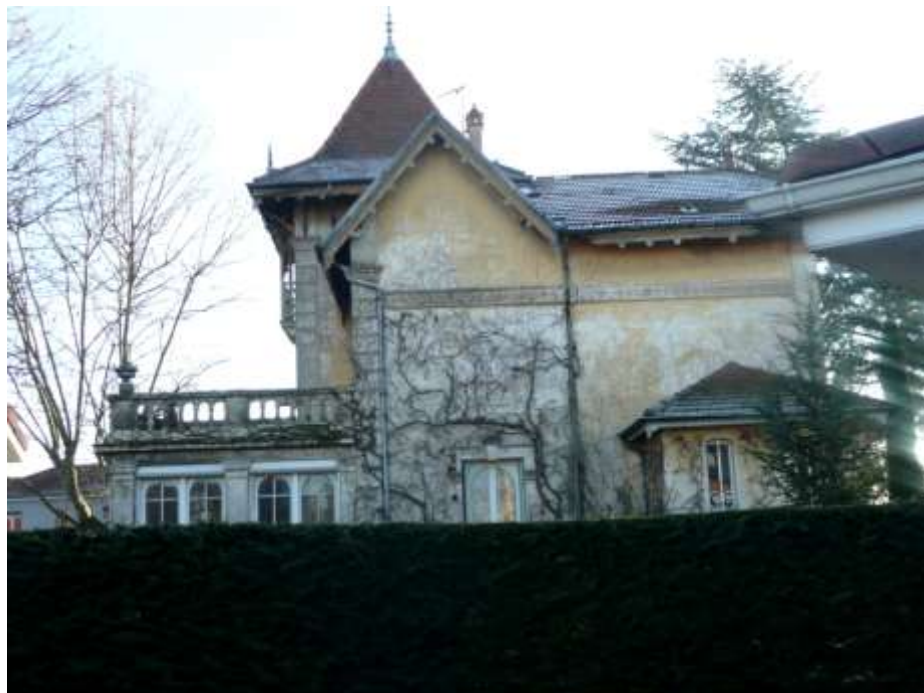
Terrasse à balustrade au dessus d'une salle dotée d'une verrière
