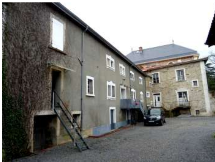
Façade sur la cour du bâtiment ancien, avec escalier conduisant à la chapelle
