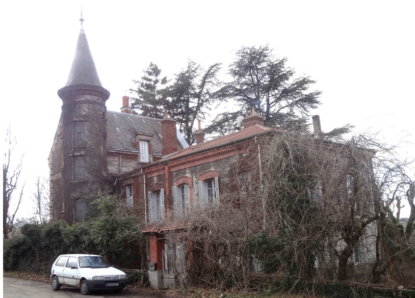
façade arrière : au premier plan, le bâtiment le plus ancien
