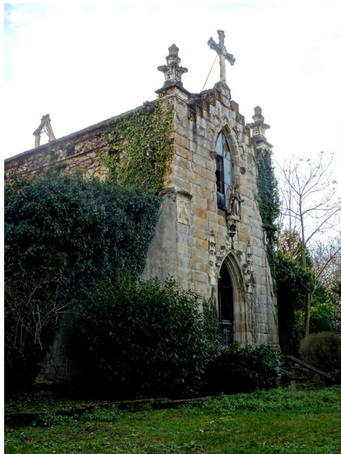
La chapelle est envahie par la végétation
