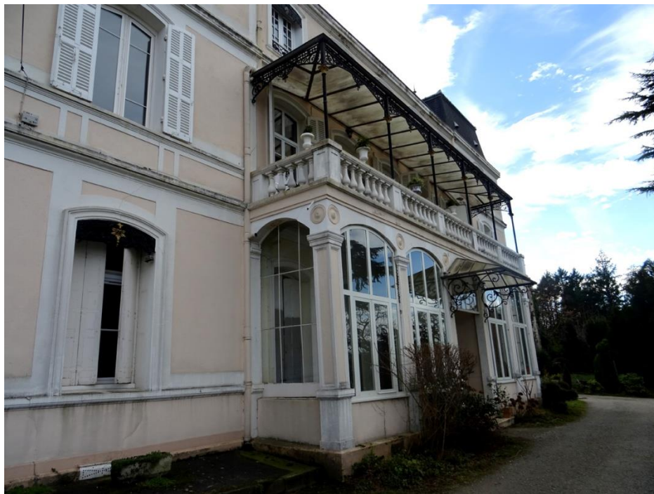
Loggia et terrasse
