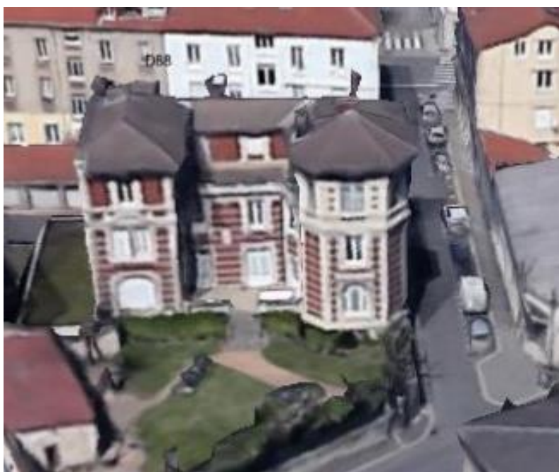
Vue aérienne. Façade avec deux avant-corps encadrant le bâtiment central
