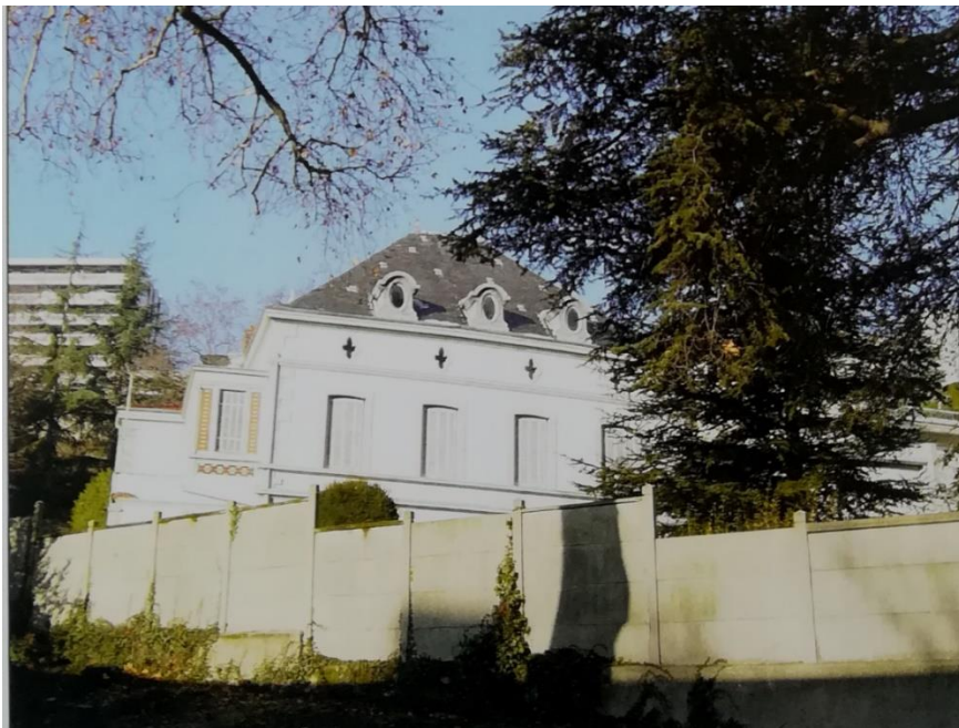
Façade est du bâtiment en 2006. Photo B. Gurcel
