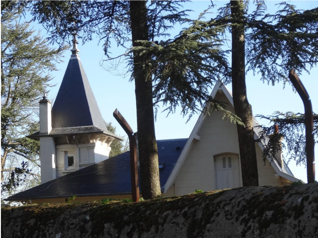
Vue de la toiture
