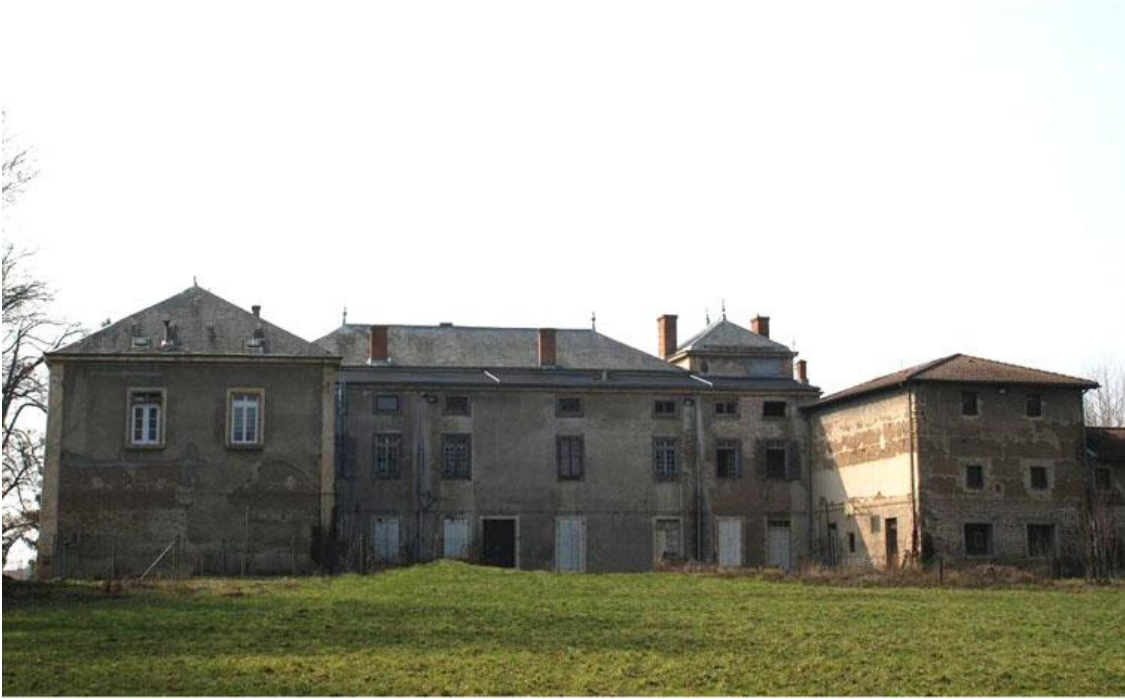
Vue de la façade arrière
