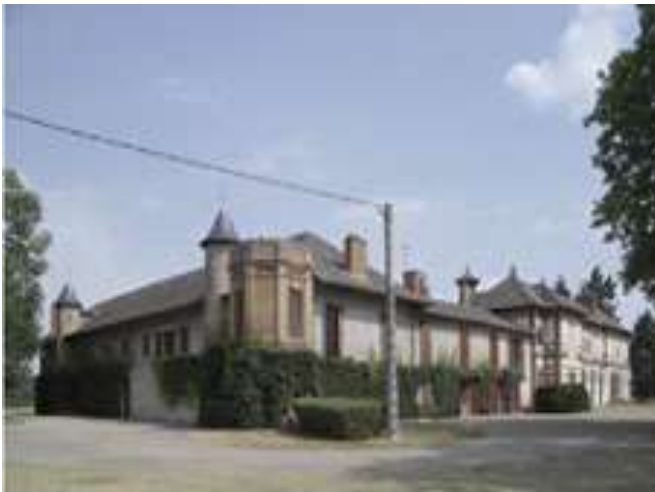
Vue arrière depuis le nord-est
