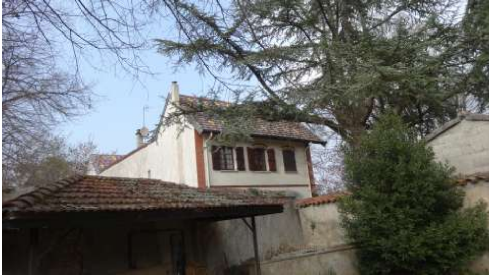
Bâtiments de la ferme. Aujourd'hui séparés du reste de la propriété et aménagés en appartements. Toitures en tuiles polychromes
