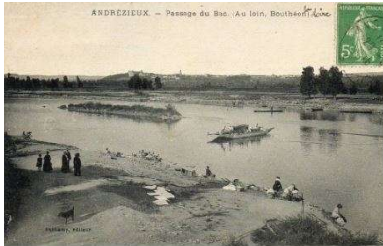
Traversée de la Loire par bac à Andrézieux
