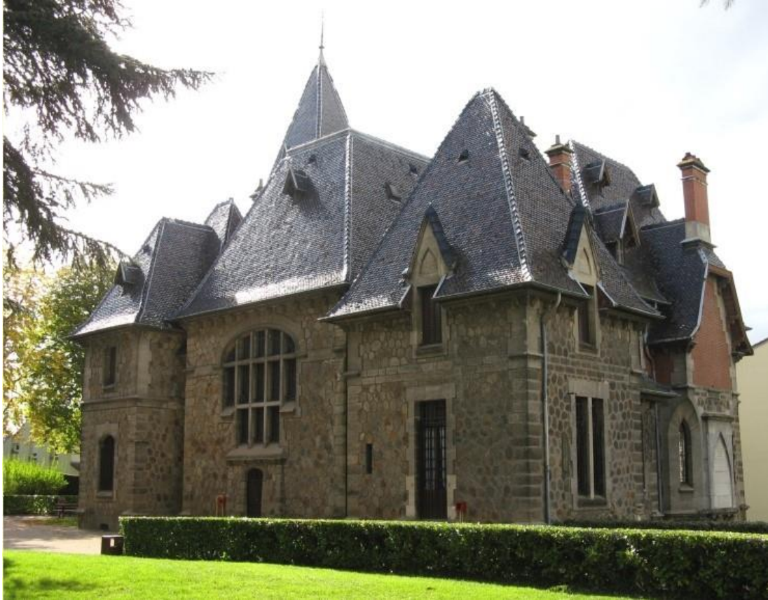
Vue arrière de la maison
